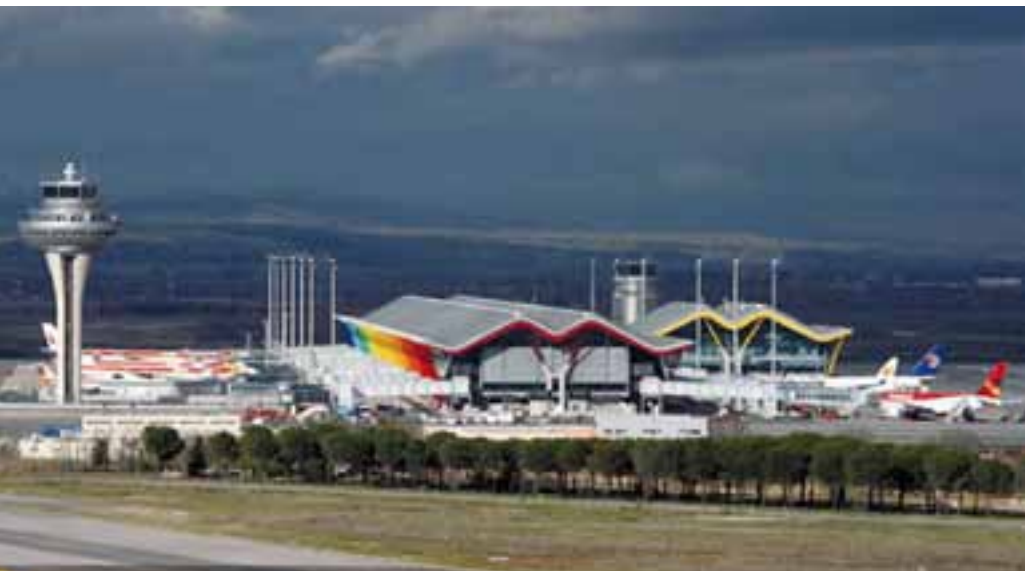
Terminal satélite de la T4
